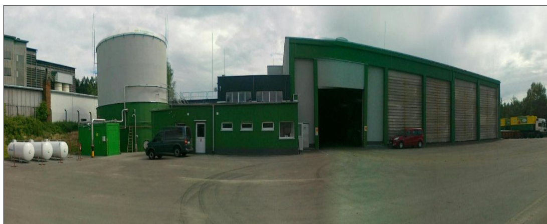
Obr. 70 Bioplynová stanice na zpracování biologicky rozložitelného komunálního odpadu. Zdroj: Fermga.
