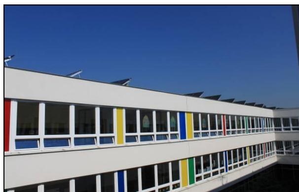
Obr. 55 Střecha ZŠ Kamínky Foto: V. Doskočilová
