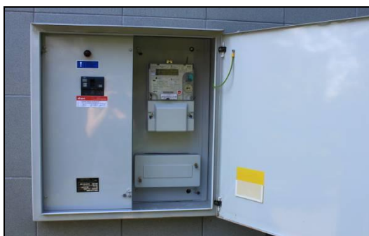
Obr. 61 Připojné místo společnosti E.ON a.s. Foto: V. Doskočilová
