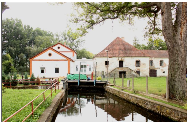
Obr. 24 Objekt MVE Červený mlýn v obci Březina. Foto K. Zákoutská
