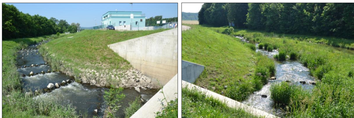
Obr. 22 Rybí přechod u MVE Bulhary. Foto K. Zákoutská
