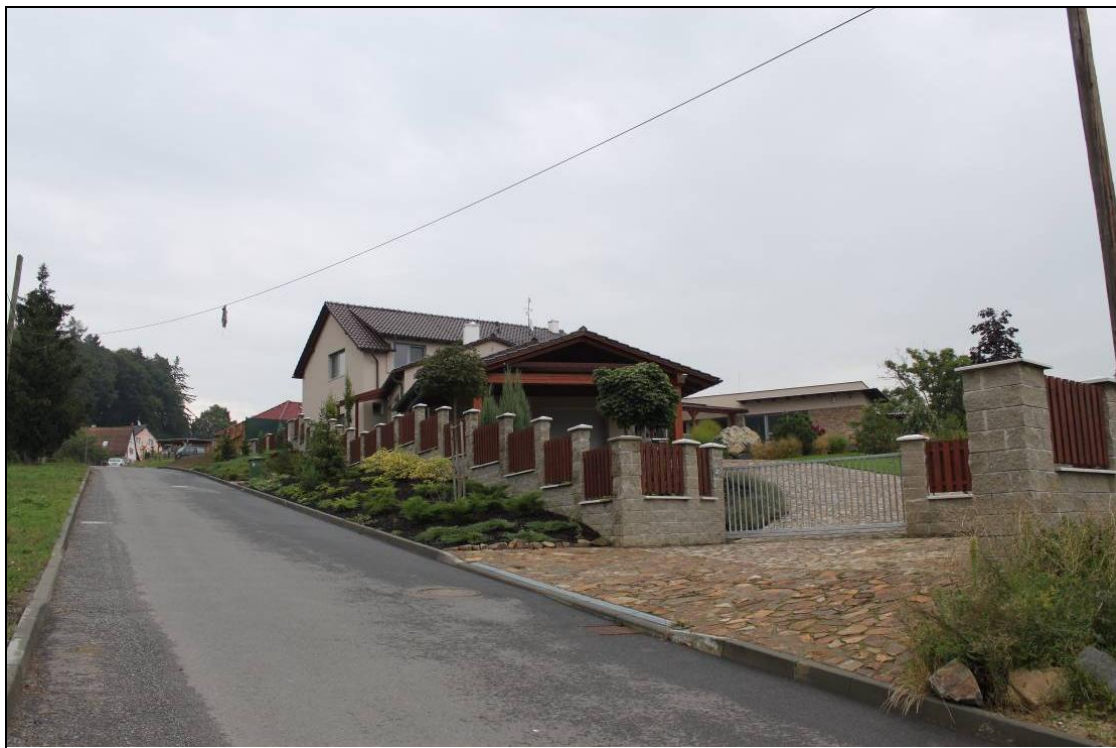
Obr. 85 Rodinný dům v Pístovicích, vytápěný pomocí plošného kolektoru. Zdroj: H. Lincová
