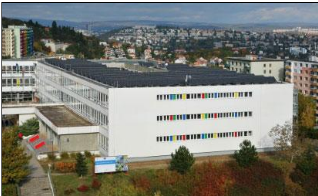
Obr. 64 ZŠ Kamínky s fotovoltaickou elektrárnou. Zdroj: Silektro, s.r.o.
