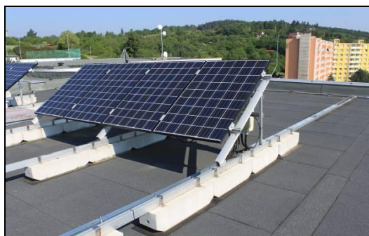
Obr. 59 Solární panely Kyocera KC 205 GHT-1 Foto: V. Doskočilová
