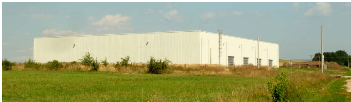
Obr. 17 Jeden ze skladových objektů, který vyrostl v původně zemědělské krajině severně od Šlapanic. Foto A. Vaishar
