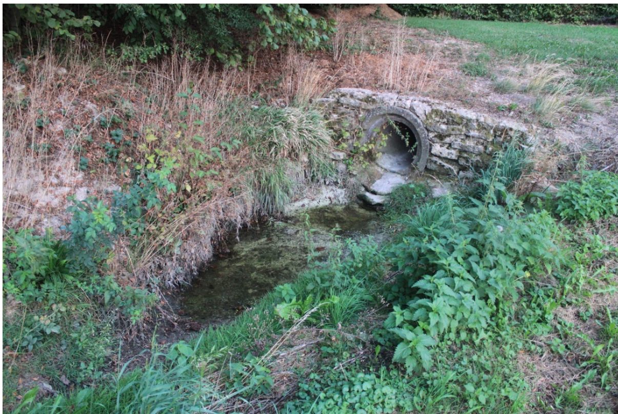
Obr. 120 Odtok z požární nádrže. Foto V. Stodolová
