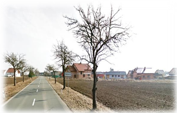
Obr. 22 Výstavba RD v obci Pňovice (ORP Litovel)
