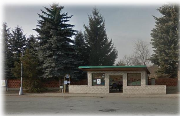
Obr. 25 Autobusová zastávka v Pňovicích (ORP Litovel)
