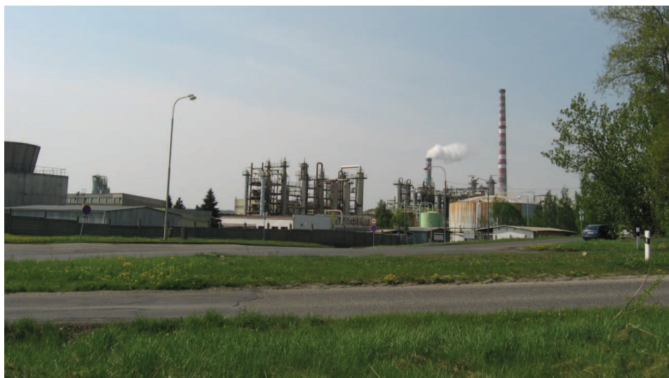
Obr. 22 Paroplynová elektrárna Vřesová; Foto: Z. Lipovská
